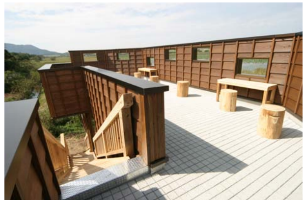
屋上 観察用デッキ
